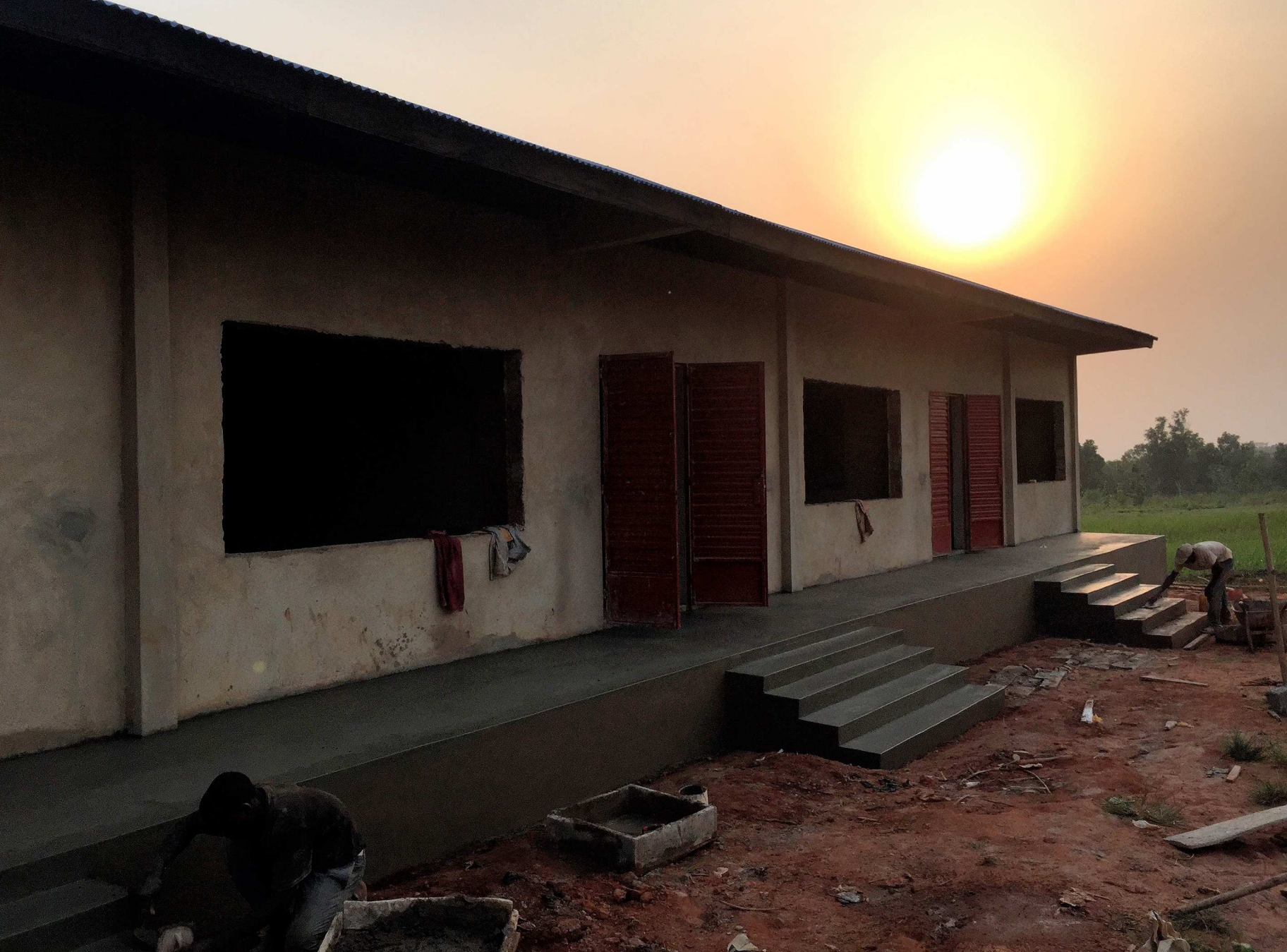
Sur le chantier
